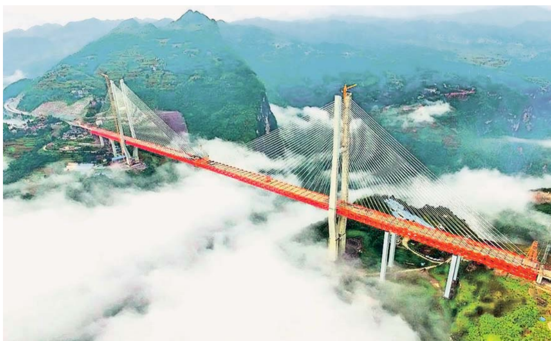
EL PUENTE MÁS ALTO DEL MUNDO FORMA PARTE DE LA AUTOPISTA QUE UNE LAS CIUDADES DE HANGZHOU, CAPITAL DE LA PROVINCIA ORIENTAL DE ZHEJIANG, Y RUILI, EN YUNNAN.
