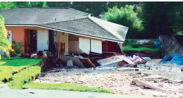
EL HUNDIMIENTO DEL SUELO NO OCASIONÓ MUERTOS NI HERIDOS.
