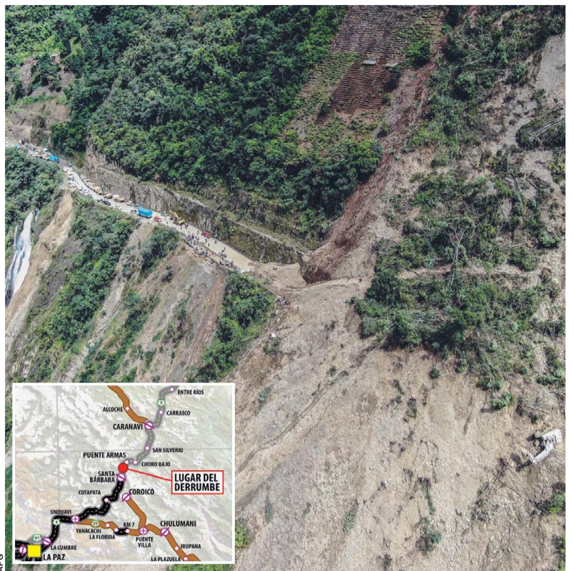
DESlizamiento COBRÓ 15 VIDAS.
